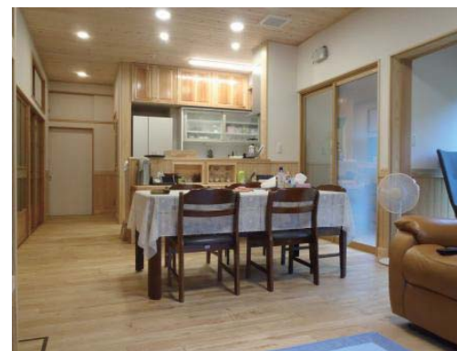
地域材を利用した新築住宅 （床材は地域のクリ材）
