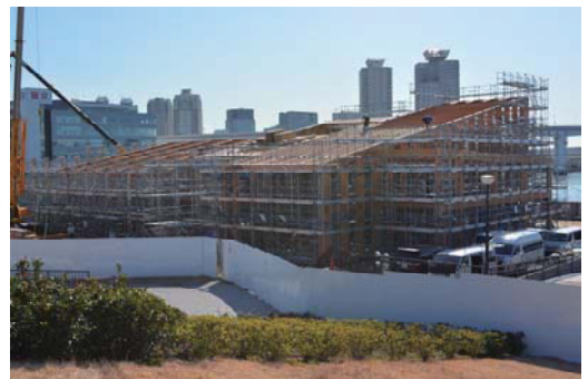
秋田スギ製品を供給した建設中の非住宅物件(東京都江東区/豊洲)
